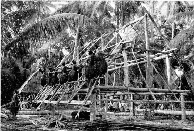
Abb. 5. Bau des Schlafhauses
