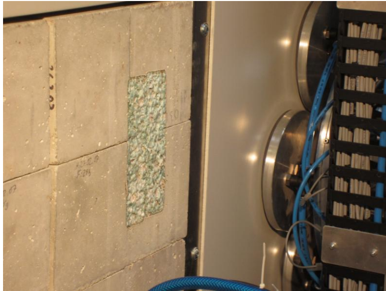
Abbildung 35: zwei nacheinander bearbeitete Spuren auf der Betonoberfläche
