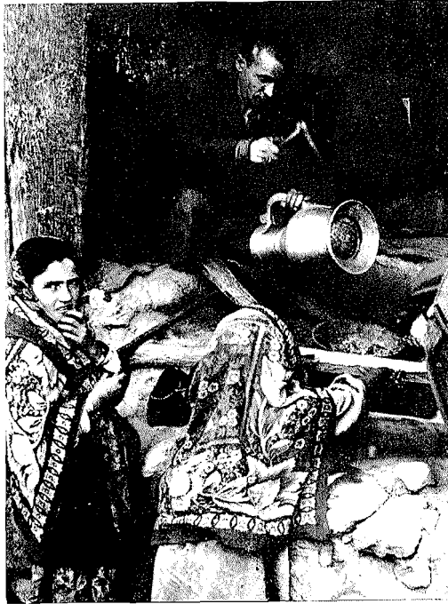
Abb. 5. Ein Kupferschmied im Bazar von Faizabad bei der Herstellung einer kupfernen Wasserkanne
