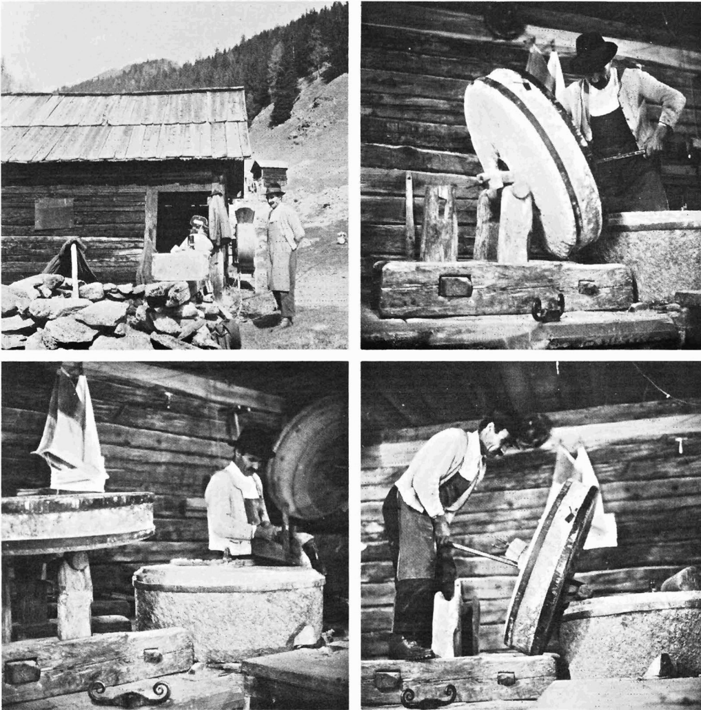
Abb. 3. a) Der Weißbergbauer vor seiner Mühle; b) Abheben des Läufers; c) Schärfen des Legers; d) Auflegen des Läufers
