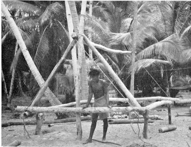
Abb. 4. Konstruktion des Daches auf provisorischen Stützen
