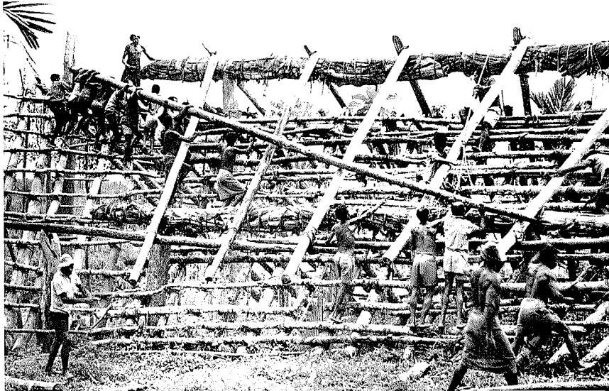
Abb. 2. Bau des neuen Männerhauses von Mene in Gemeinschaftsarbeit. Die Männer bewegen sich auf dem Baugerüst (oben links: YESSOMARI), um eine Firstpfette auf die herausragende Tragkonstruktion des Daches aufzulegen
