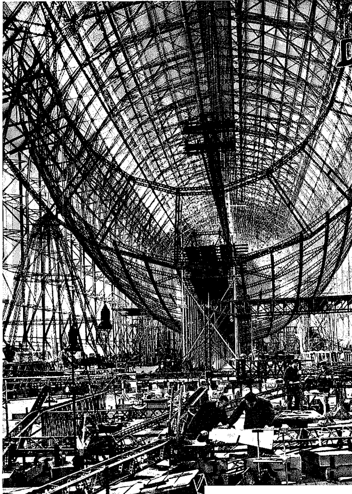
Bedring-Montage des L. Z. 129. Das Bild gibt einen Begriff von den enormen Ausmaßen des neuen Zeppelins.
