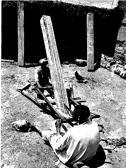
Abb. 5. Arbeitsstadium kurz vor dem Umdrehen des Balkens
