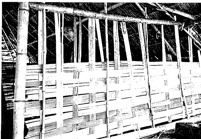
Abb. 13. Herstellen einer Hauswand
