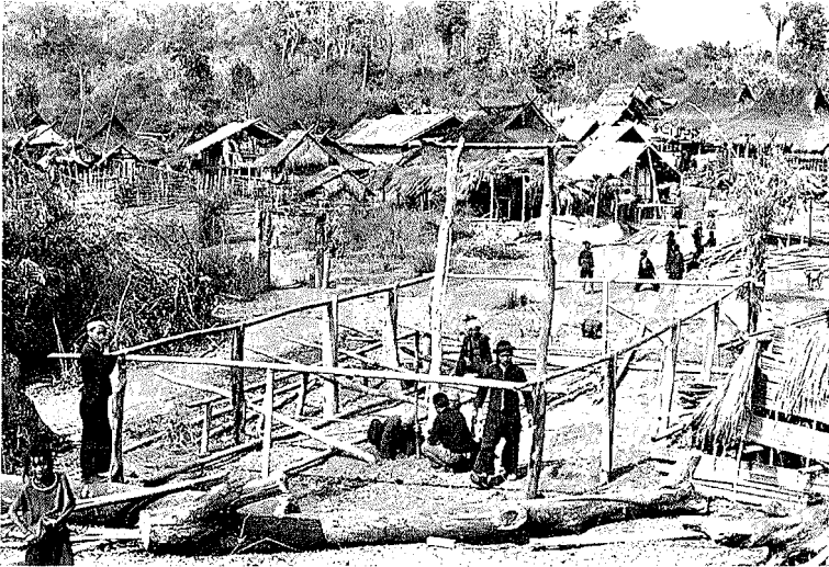
Abb. 10. Setzen der Firstsäulen
