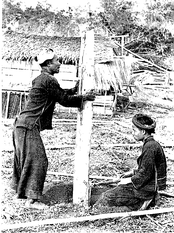
Abb. 9. Setzen des ersten Hauspfostens
