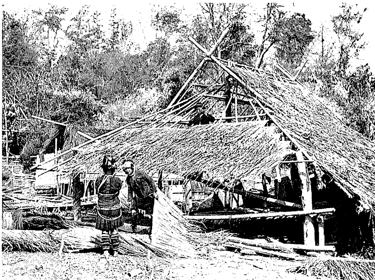
Abb. 12. Decken des Daches
