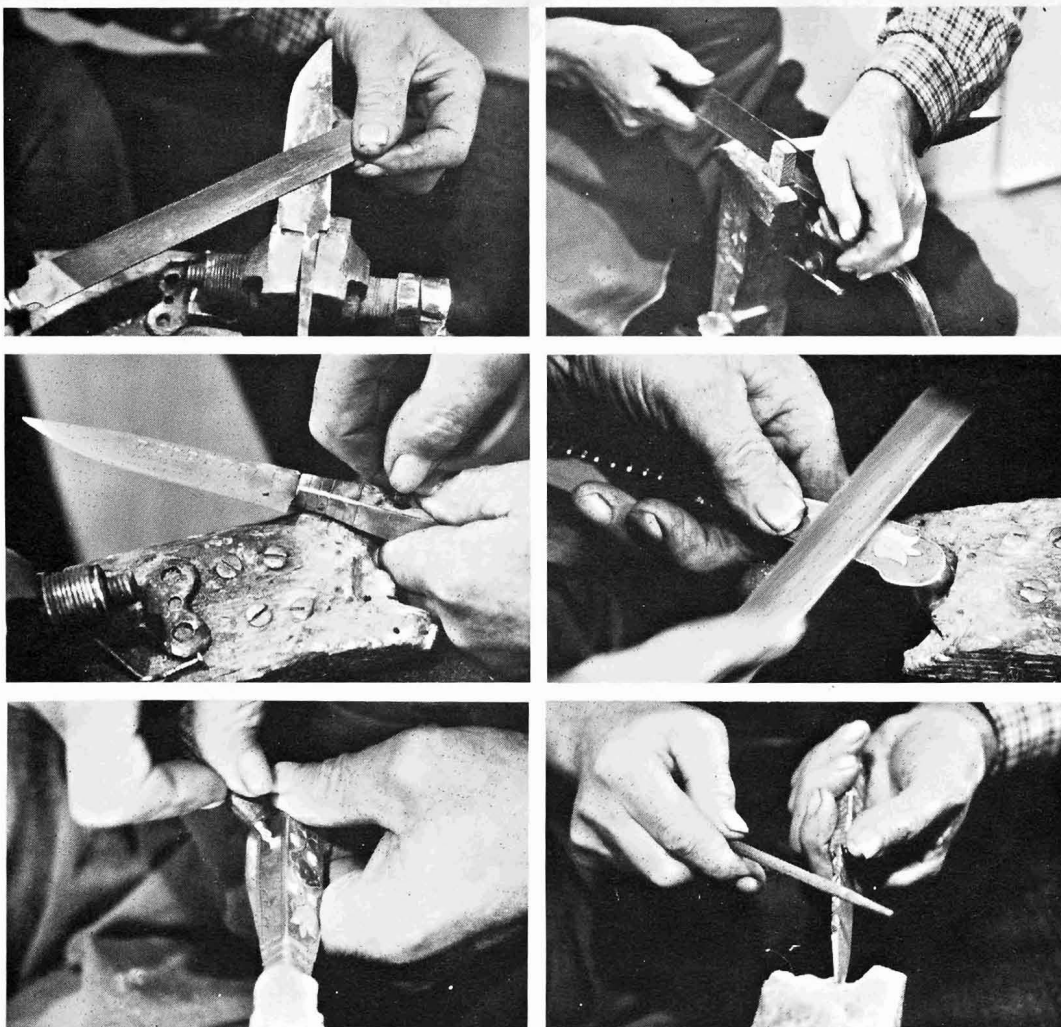
Abb. 2. Herstellungsphasen des Messers
