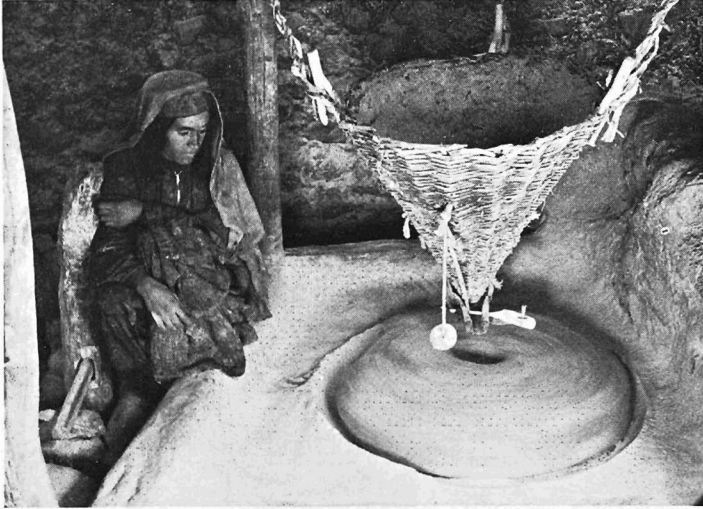
Abb. 11. Mahlen von Getreide in einer wassergetriebenen Mühle
