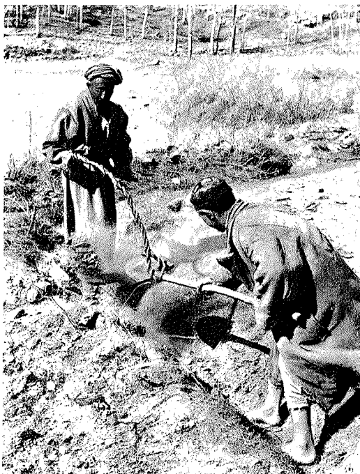
Abb. 11. Ausheben eines Grabens mit Zugspaten
