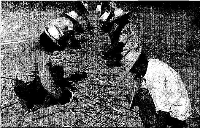
Abb. 1. Vorbereitung des Grundnetzes durch Festbinden kurzer Stangen
