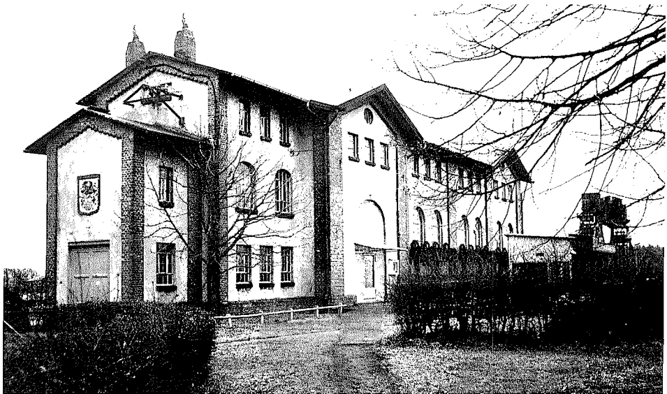
Abb. 5. Wasserkraftwerk in 3101 Hambühren-Oldau 1973
